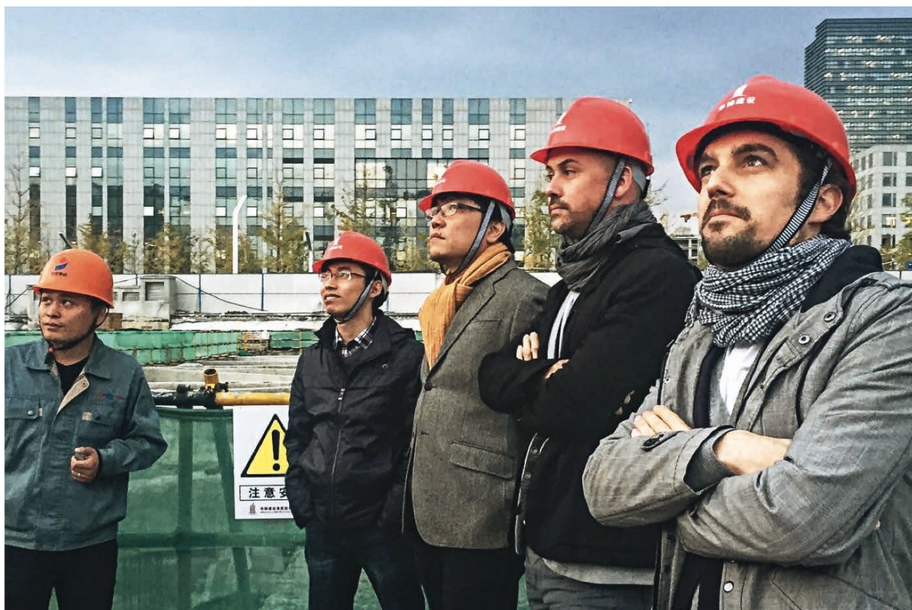
Die Partner von playze Pascal Berger, Marc Schmit und He Mengjia (v.r.n.l.) auf der Baustelle in Ningbo
